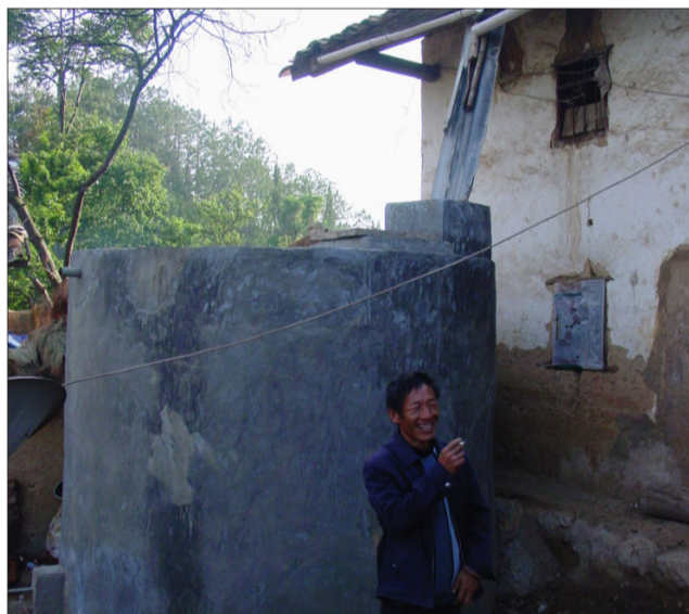
Un récupérateur d'eau de pluie réalisé grâce à l'ONG. Photo ID
