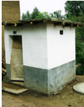
Latrines reliées au réservoir
